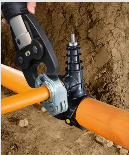
Hausanschlussleitung verlegen, verpressen und anschließend Druckprobe durchführen.
