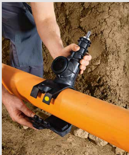
Anbohrarmatur aufsetzen und in erste Raste einrasten.
