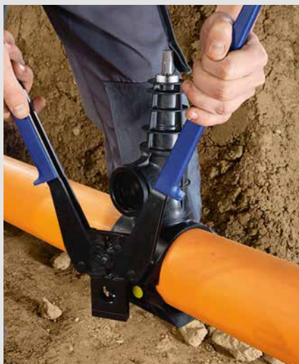
Armatur mit Handwerkzeug oder Pressgun verpressen.
