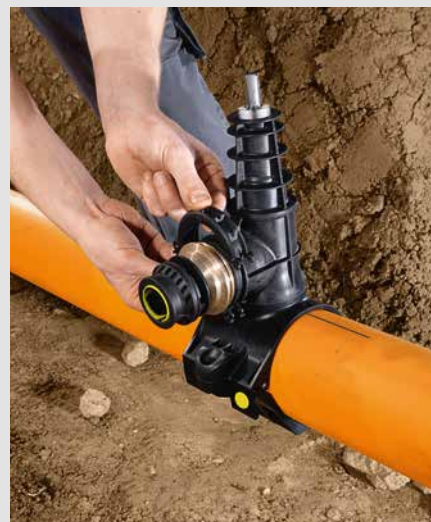
Geopress G-Anschlussstück einsetzen und sichern.
